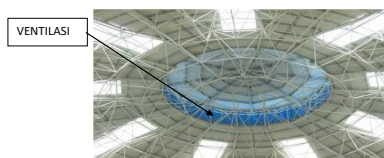
Gambar 11. Konsep ventilasi pada atap
