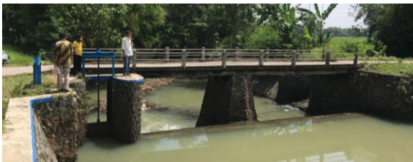
Gambar. 2. Tampak eksisting jembatan
