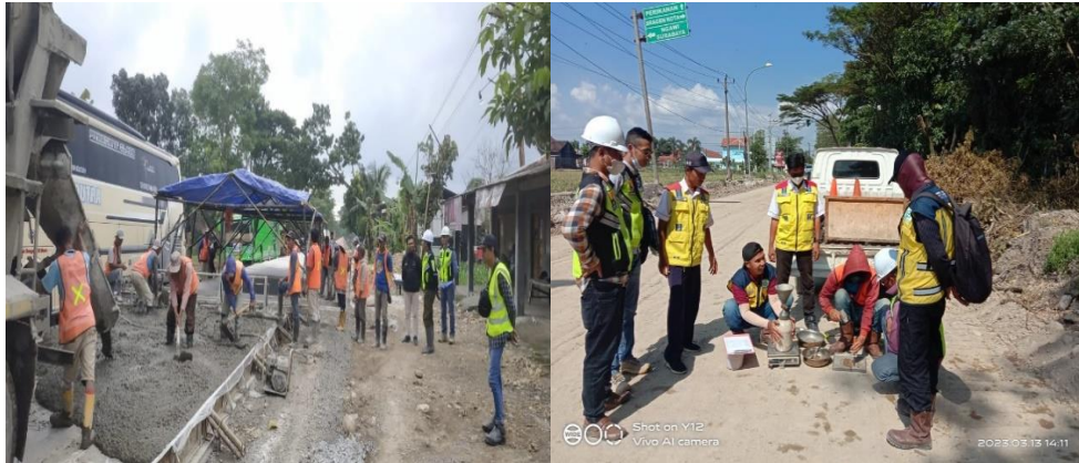
Gambar 1 Kegiatan pengawasan pelaksanaan pekerjaan rekonstruksi jalan (Sumber: data pribadi)
