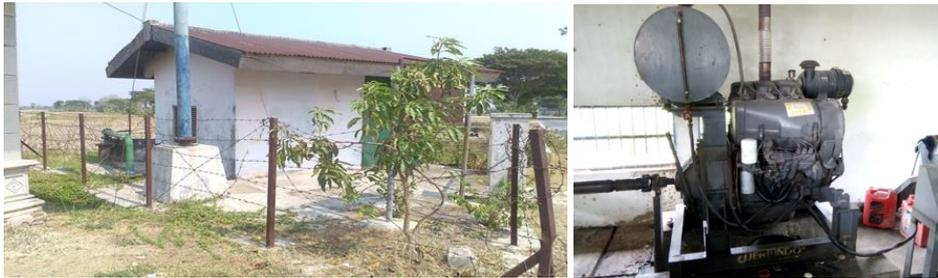
**Gambar 9. Rumah Pompa dan Pompa**
