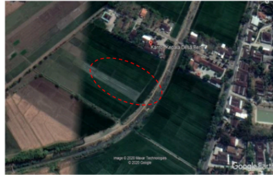
Gambar 2. Lokasi Pipa Pralon (Talang) Irigasi DI Ngarum
