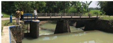
Gambar. 2. Tampak eksisting jembatan
