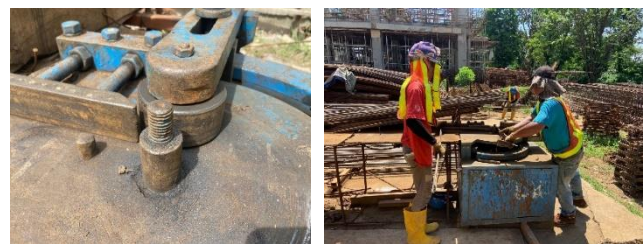
Pengecekan Mesi BAR Bending yang digunakan
