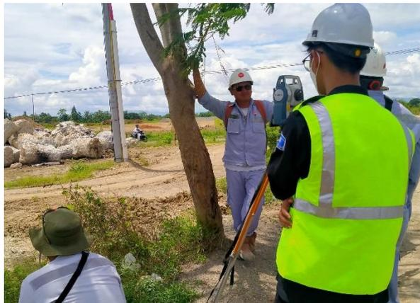
Gambar 5. 19 survey penentuan titik
