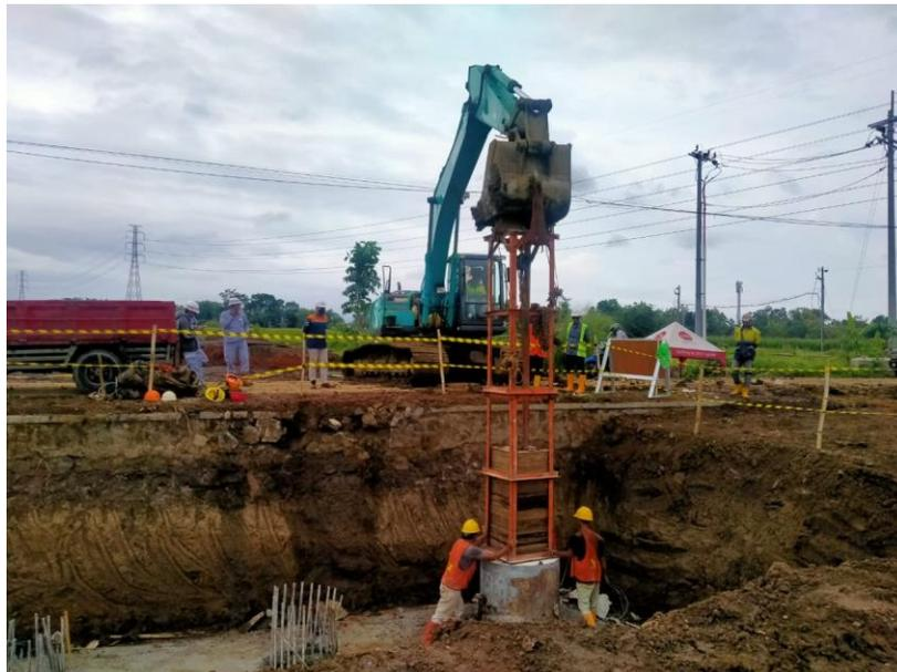
**Gambar 3. 2** Proses Pengujian PDA pada *Bored pile*
