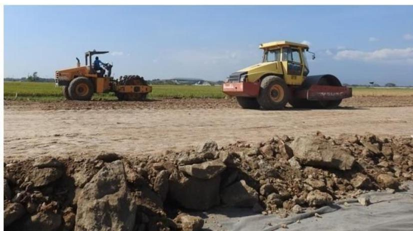
**Gambar 4. 10** Proses Pemadatan Tanah Menggunakan
