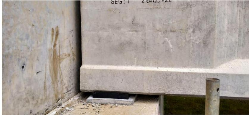
**Gambar 4. 17** Pemasangan *Bearing Pad* dan *Elastomeric*
