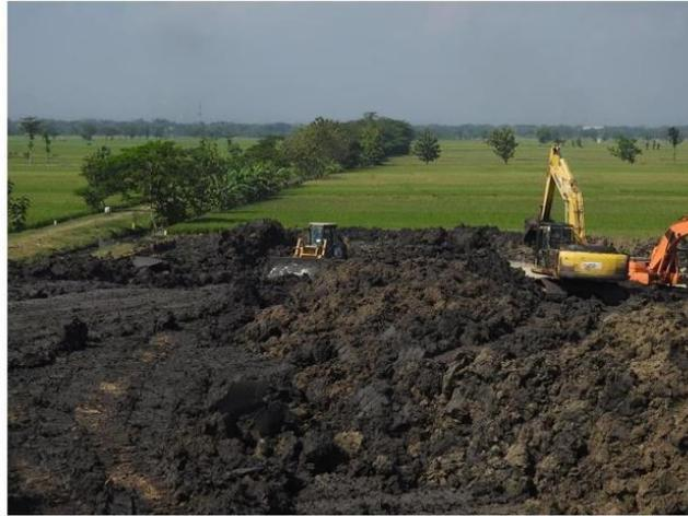
**Gambar 4. 4** Proses pengupasan tanah menggunakan *bulldozer dan excavator*
