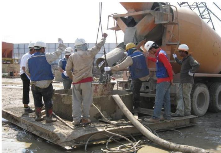
**Gambar 5. 27 Penuangan beton**
