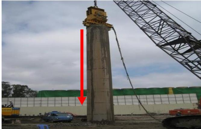
**Gambar 5. 22** Pemasangan Casing
