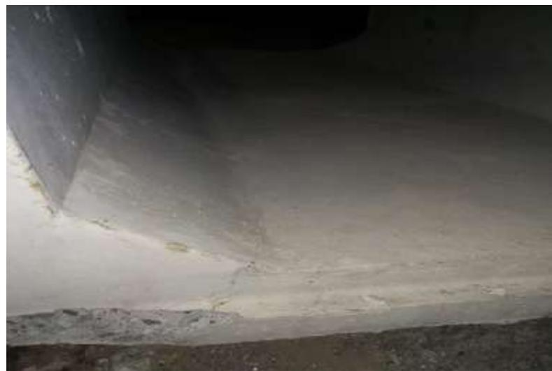
Gambar 4.18 Gambar U-ditch yang mengalami kerusakan pada saat pengiriman
